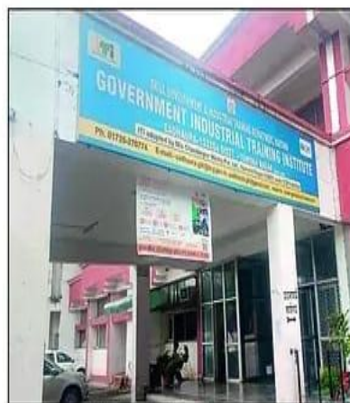
साढ़ौरा आईटीआई का भवन।
