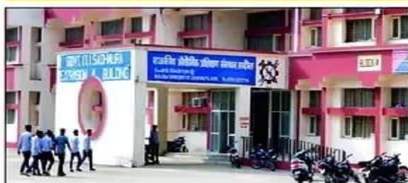
साढौरा आईटीआई का भवन। आर्काइव
